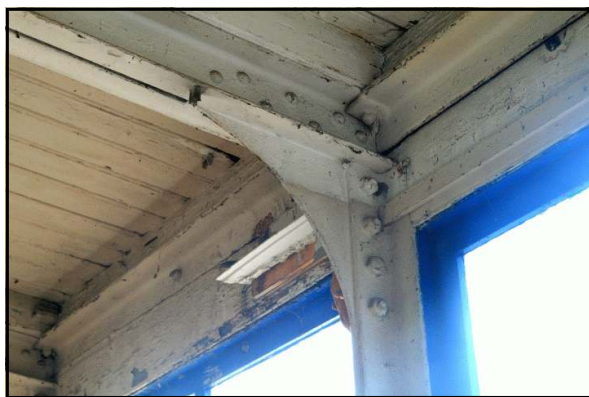
Een fragment van de ijzeren constructie in de uitbouw van Gaagweg 6. Foto auteur.
