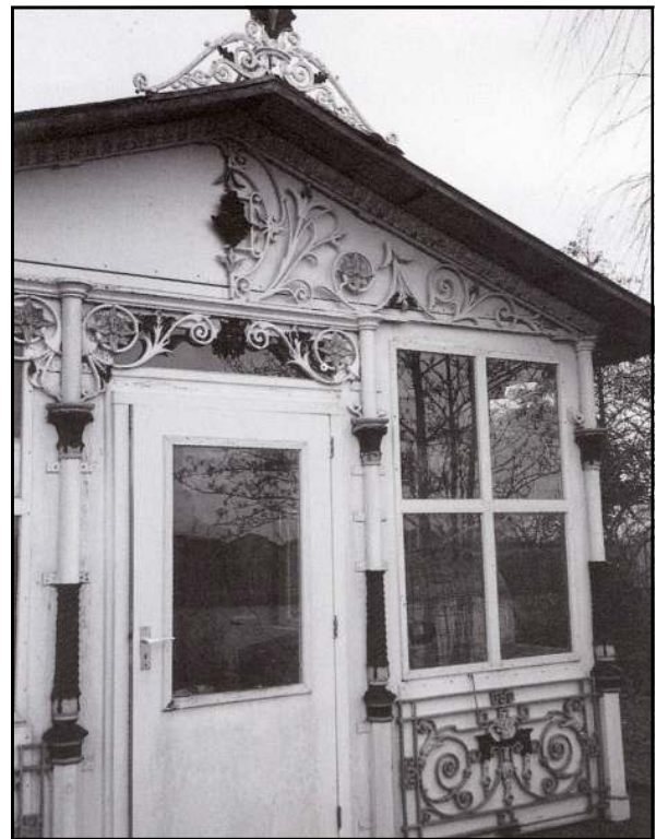
Het tuinhuis na een gedeeltelijke restauratie, met nog veel intacte gietijzeren onderdelen.
