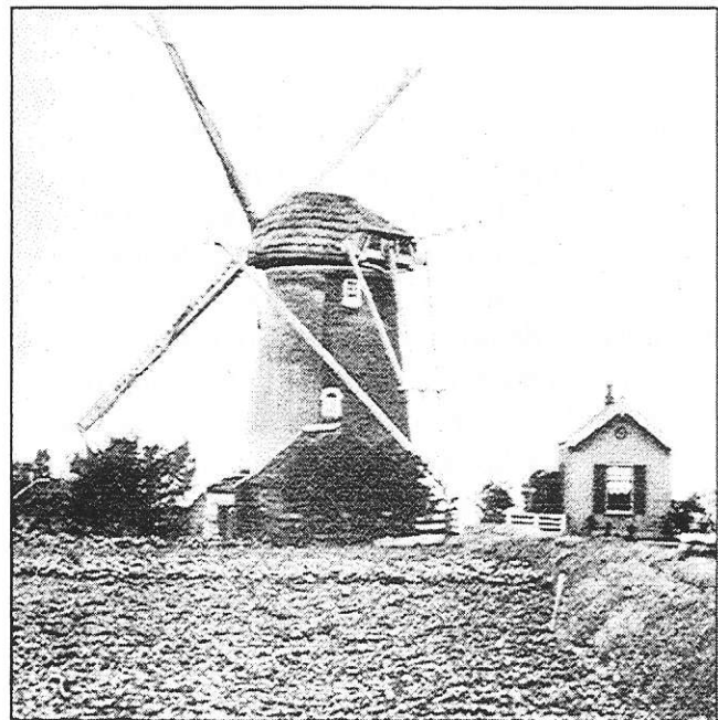
De Voordijkshoornse molen, gebouwd in 1737 ter bemaling van de Voordijkshoornse Polder. In 1924 werd in plaats van de windaandrijving een elektromotor geplaatst. In de dertiger jaren is de kap van de molen gesloopt. Situatie 1924.
